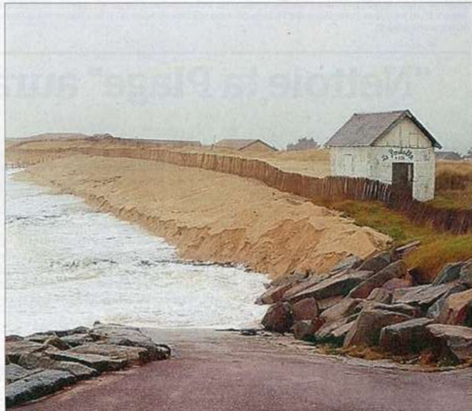
L’Association syndicale autorisée digue Nord et Centre estime que les pieux hydrauliques empêcheraient le cordon dunaire de se régénérer, du fait de la baisse du niveau de la plage.
