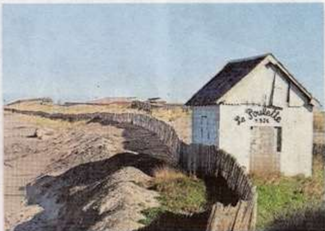
Au nord de Coutainville, le secteur de la Poulette est protégé par des garivelles et des pieux. | PHOTO: OF
