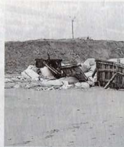
La tempête a emporté tout le sable et fortement attaqué le pied de la dune menaçant les campings juste derrière.
