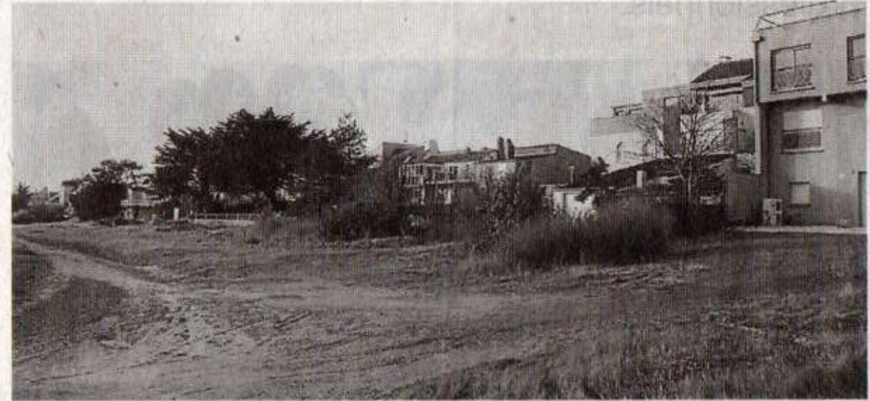
Ces maisons donnant sur le marais pourraient être inondées en cas de rupture du cordon dunaire.
