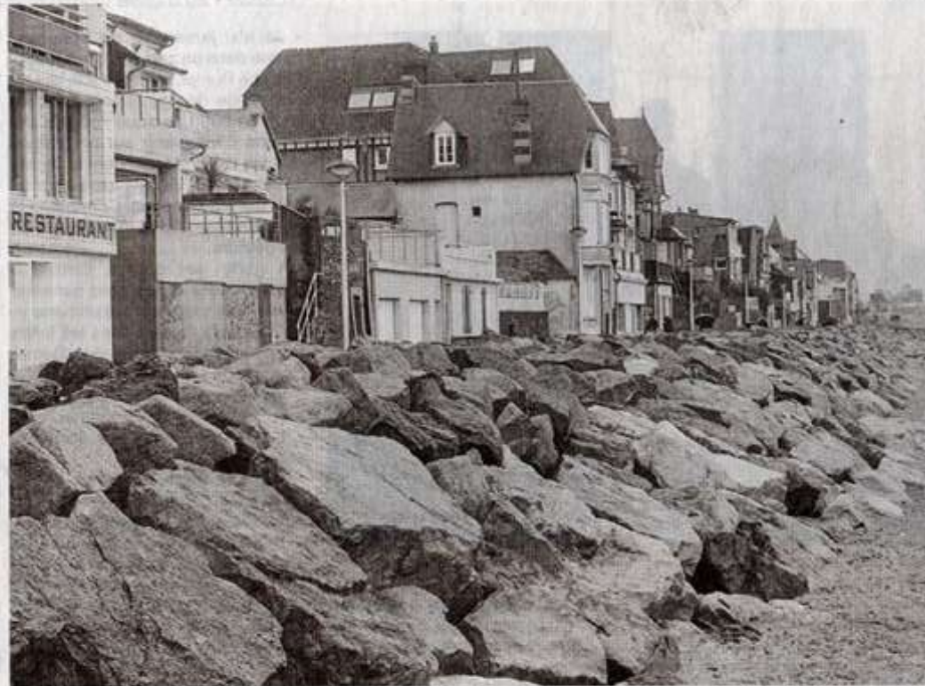
La digue du Centre à Agon-Coutainville.
